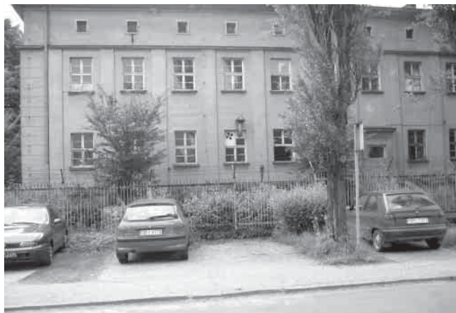
Budynek przy ul. J. Kochanowskiego
