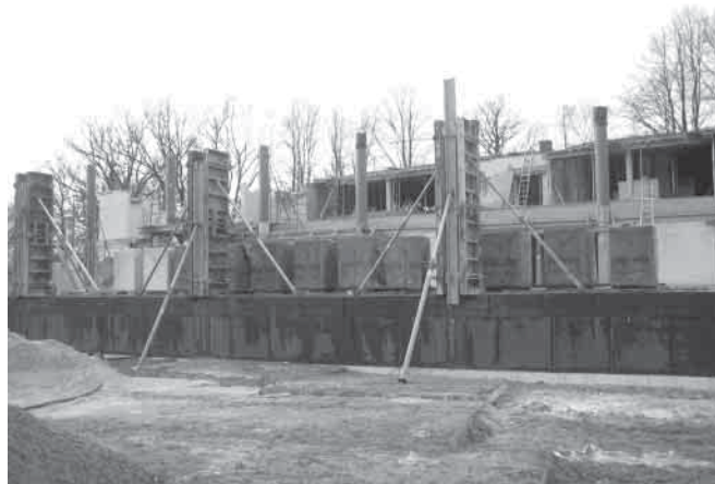
Budowa basenu krytego na MOSiR.
